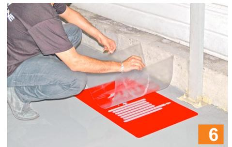
Retirer et conserver le protecteur de l'applicateur. Positionner l'applicateur sur le marquage de façon convexe.
